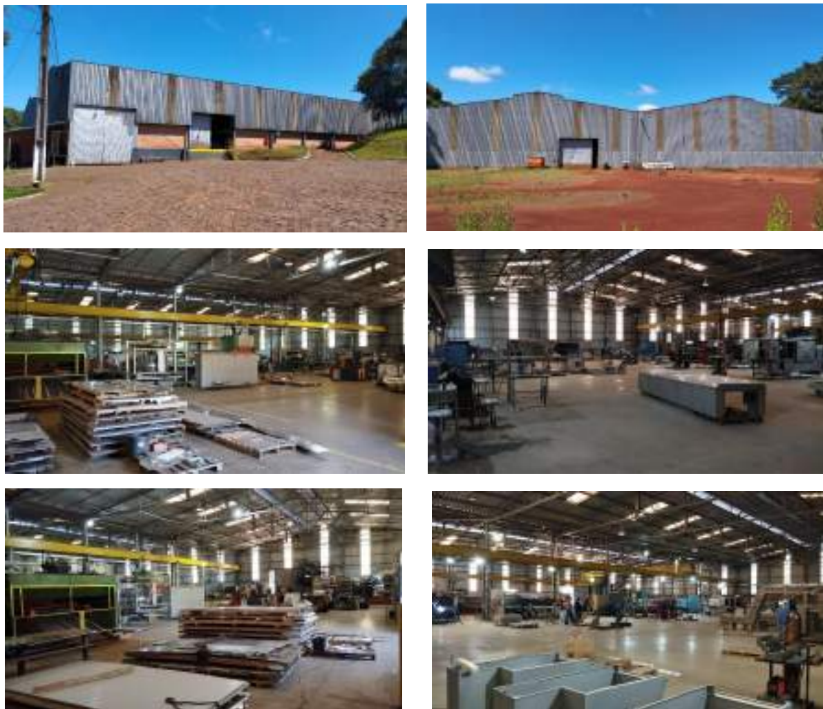
Vistas do Bloco 01 – Barracão I
